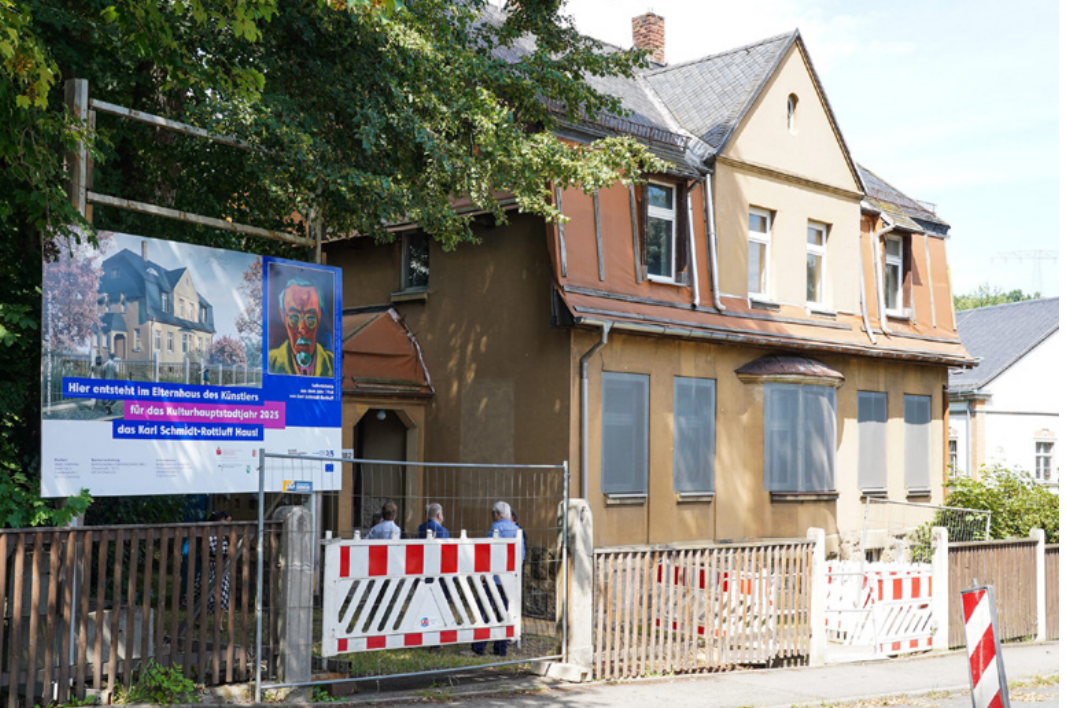
Karl Schmidt-Rottluff Haus
